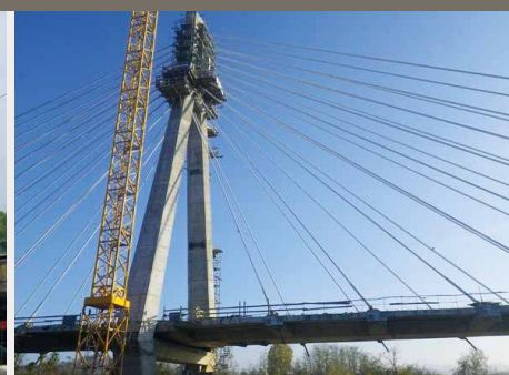
Pomical, Viadotto strallato / Cable-stayed bridge SP456 del Turchino (Cismondi)
